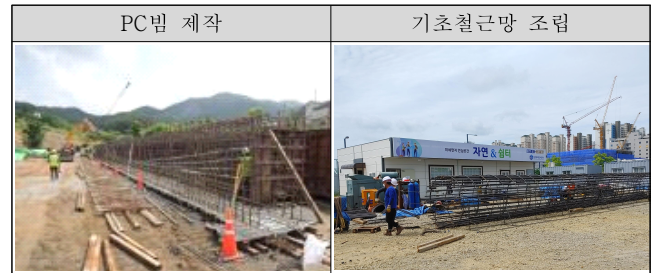
[표 6] 제작장 활용 철근 가공 및 조립
