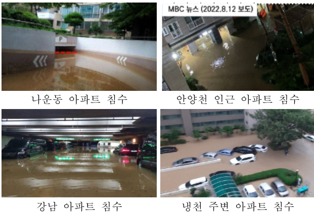
[그림 1] 지하주차장 침수 피해 사례
